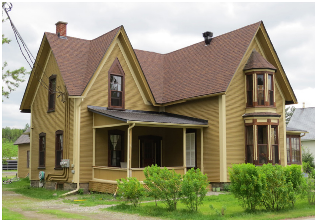
Maison avec oriel sur la façade de l'avant-corps au 8, chemin McCurdy, West Brome (1850)
