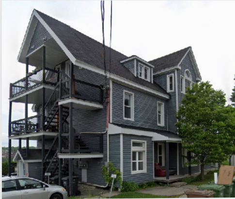
Extension du toit et changement du revêtement extérieur sur une maison de Sherbrooke
