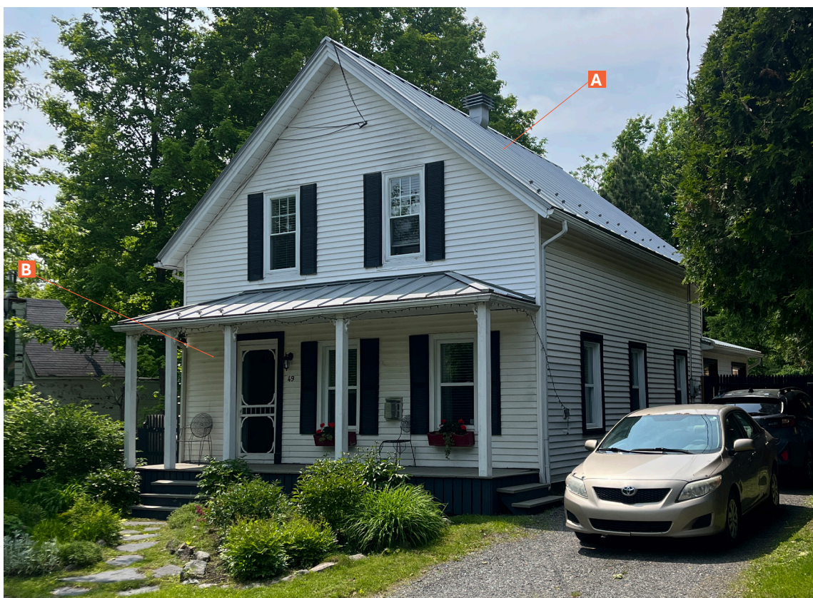
Maison vernaculaire avec façade sur le mur pignon Enclume, 2025
