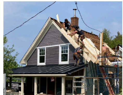
Bardeaux décoratifs découpés sur le pignon du 60, rue Lansdowne Enclume, 2025
