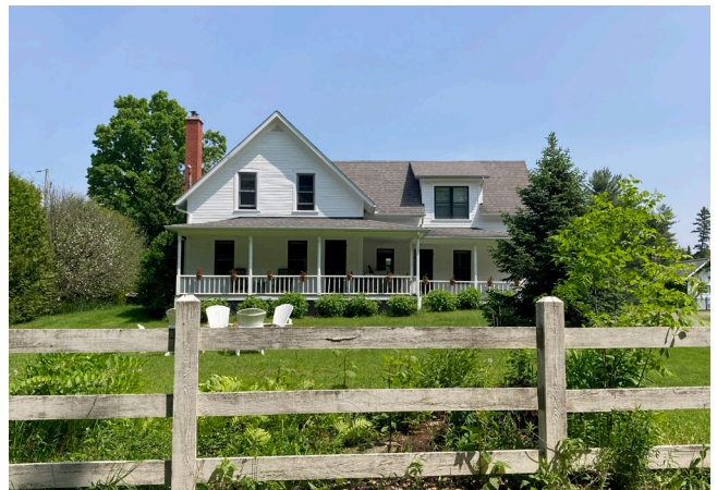
274, chemin du Centre, Bondville-Fulford (1880-1900) Enclume, 2025
