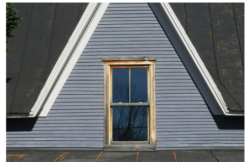
Fenêtre à guillotine en bois logée dans la lucarne-pignon du 13 rue Benoît. Claude-Bergeron, 2015
