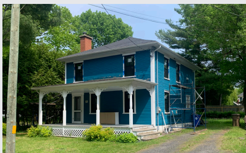
Changement des fenêtres sur le 24, rue Davignon
