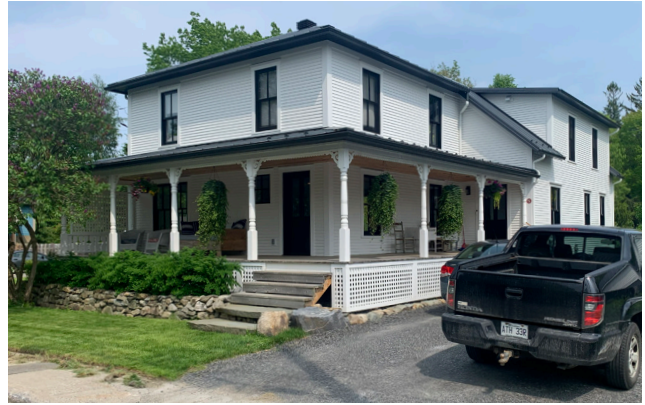
Maison en clin de bois avec une galerie couverte sur deux côtés et annexe à l'arrière au 8, rue Davignon, Knowlton (1900-1925)
