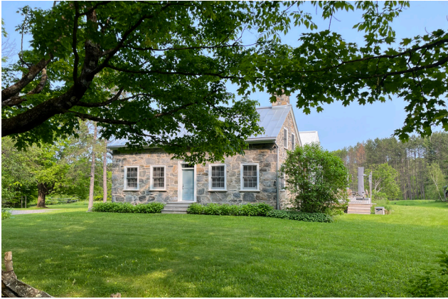
Maison en pierre au 81, chemin Spring Hill, East Hill (1849) Enclume, 2025
