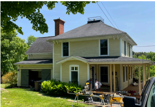
Maison à toit pavillon avec crête faîtière et tambour en façade au 134, Chemin Soles, West Brome (1930)
